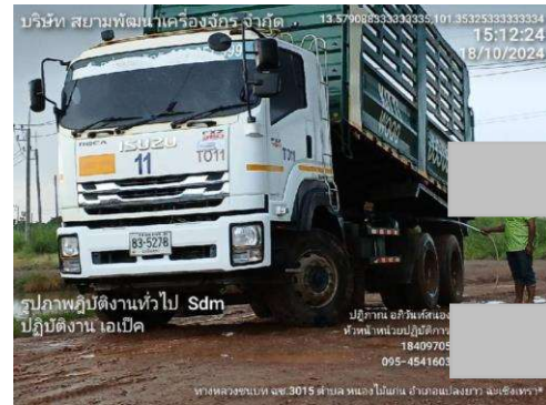
รูปที่ 2-11 การล้างล้อรถของรถบรรทุก
